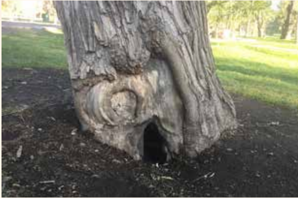
Figura 57: Árbol inclinado que además tiene un ahuecamiento en la base.
