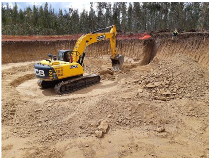
Fotografía 5-7 Excavación masiva en plataforma VÑ13
