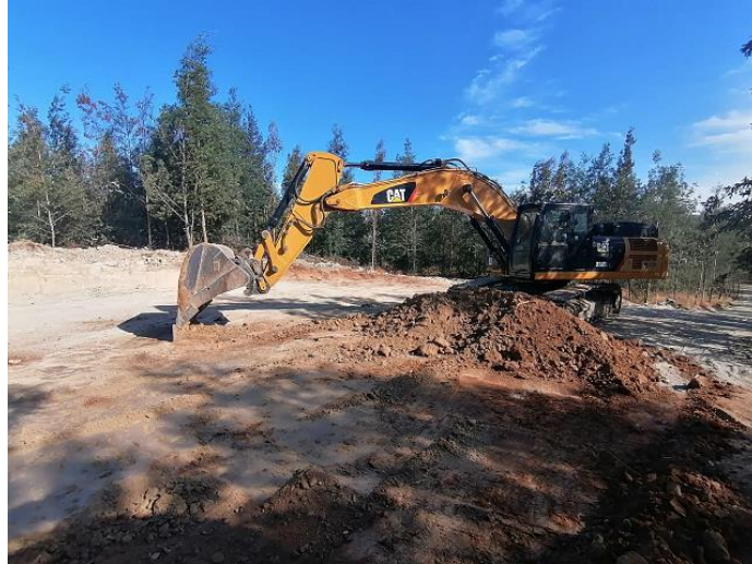
Fotografía 5-5 Excavación masiva en plataforma VÑ04
