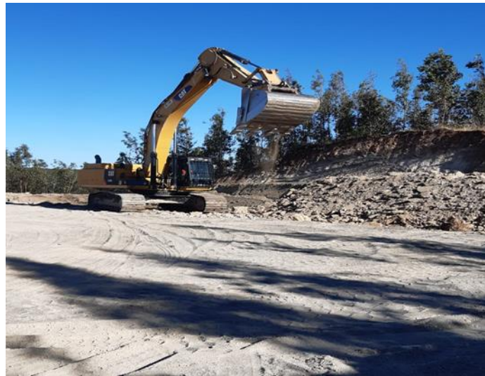
Fotografía 5-6 Excavación masiva en plataforma VÑ01
