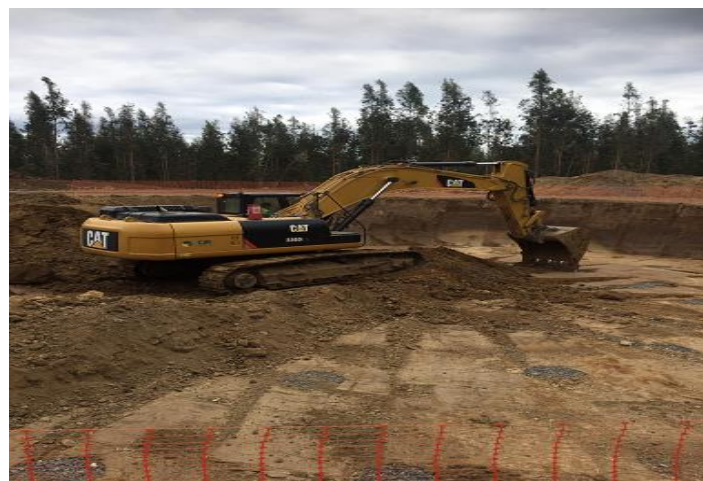
Fotografía 5-8 Excavación masiva en plataforma VÑ12
