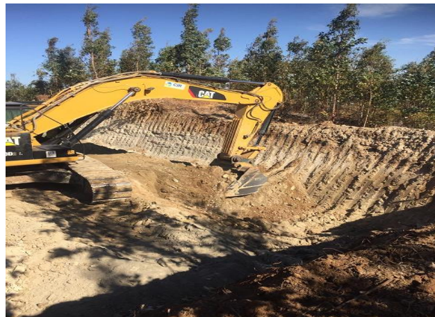
Fotografía 5-4 Excavación masiva en plataforma VÑ03
