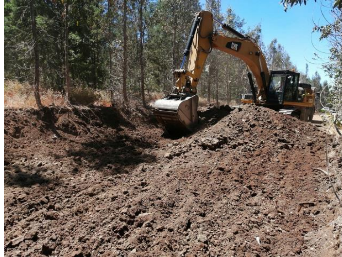
Fotografía 5-10 Escarpe realizado en vial de acceso a plataforma VÑ05
