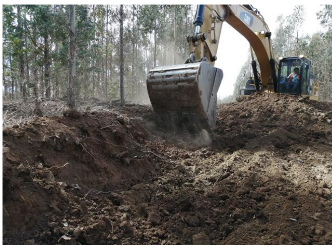
Fotografía 5-9 Escarpe realizado en vial de acceso a plataforma VÑ03
